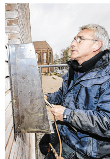
Dachdecker Günter Nick baut Notüberläufe auf dem Flachdach.
